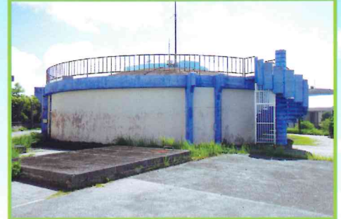
②潮平配水池 容量：850m 3
