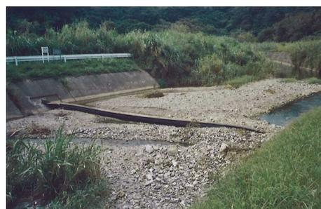
取水堰の堆積土砂状況
